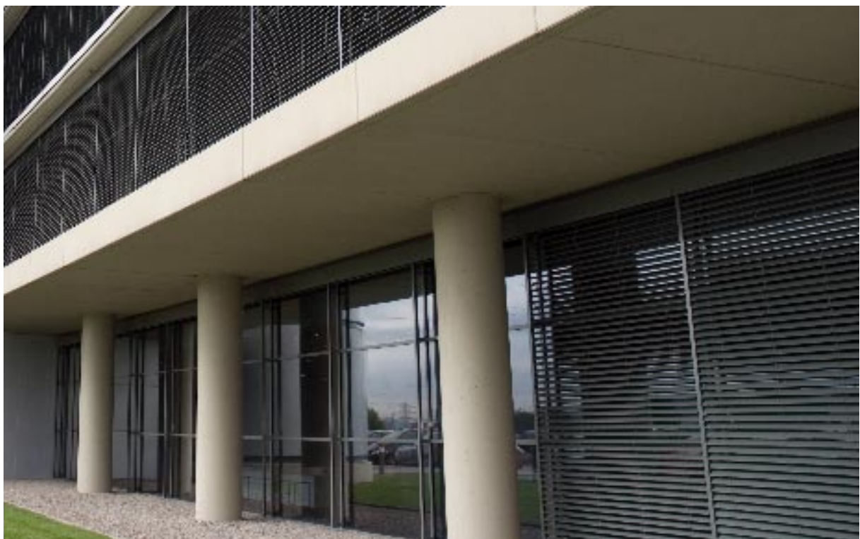
Détail d'une façade avec Maximatic® sur les balcons d'une entreprise multinationale.
