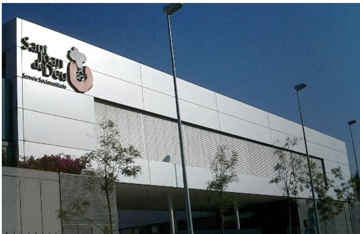
Installation de Maximatic® sur la façade d'un hôpital.
