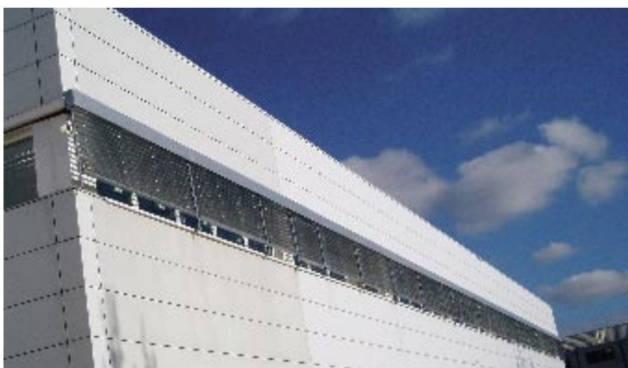
Façade d'un bâtiment public avec installation groupée de Maximatic®.
