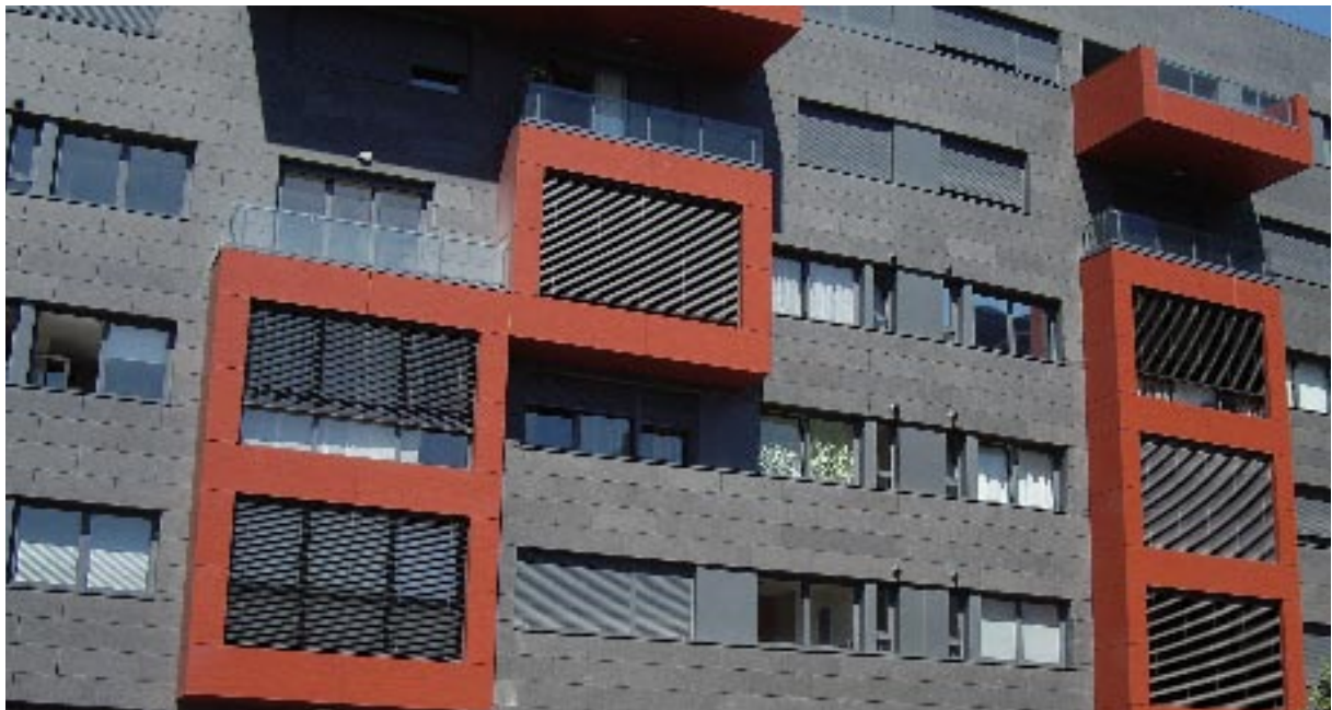
Installation Maximatic® dans un immeuble d'habitations.
