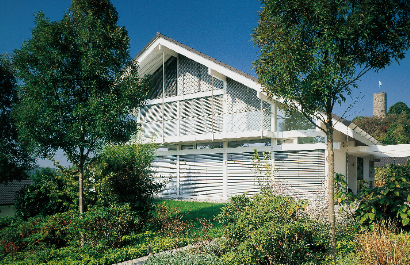
Habitation avec installation de Maximatic® incliné
